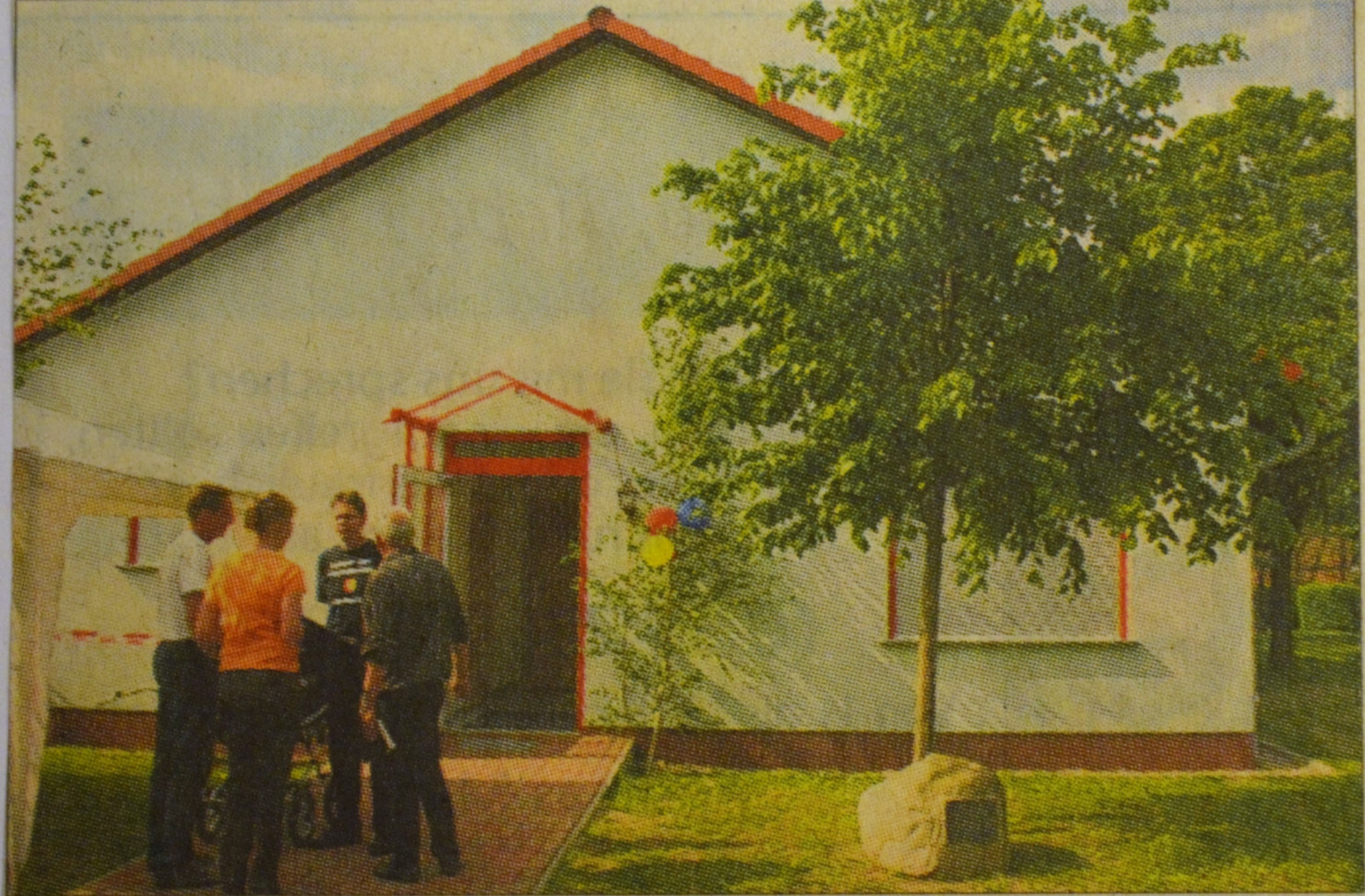
Der Anbau am Feuerwehrgerätehaus Grimme hielt zum Pfingstgelage der ersten großen Bewährungsprobe stand. Foto: Petra Wiese
